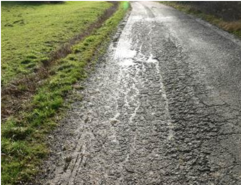
Abbildung 4 Wirtschaftsweg zur Wasserfüllstelle
